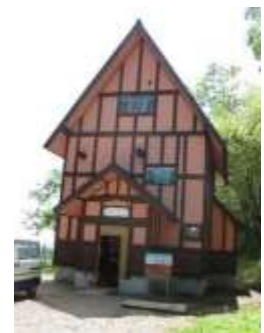
古民家再生住宅
